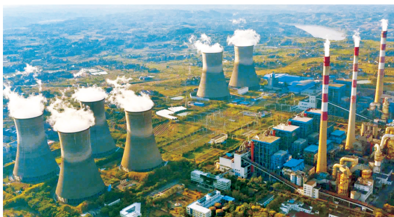
中国华电集团四川广安发电有限责任公司“火力全开”保发电。
