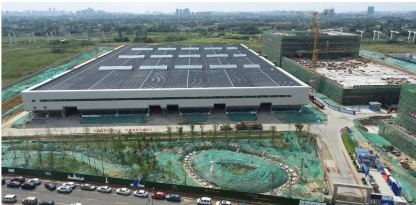
成都智能制造装备产业用房建设一期项目研究院及配套产业用房主体已封顶。
