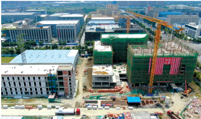
建设中的东方氢能产业园。
