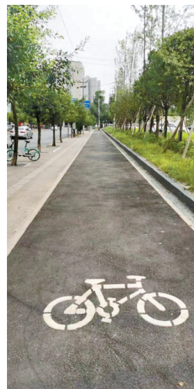
整改后的锦江区琉璃路沙河桥至中环路段。
