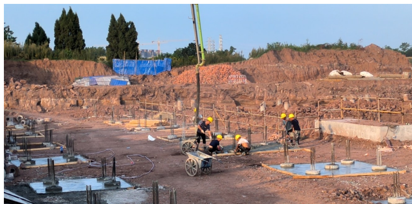
8月2日傍晚,工人们正抓紧时间抢工期。
