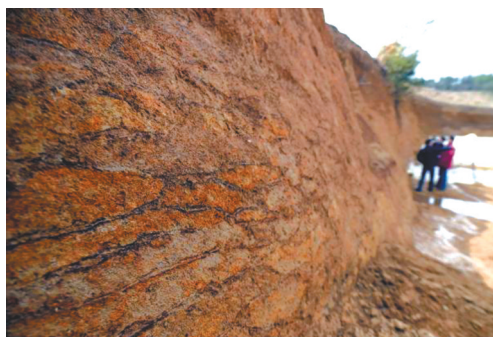
良渚古城外围水坝的关键部位以“草裹泥”工艺堆垒加固。（黑色细条为草碳化后的痕迹）
