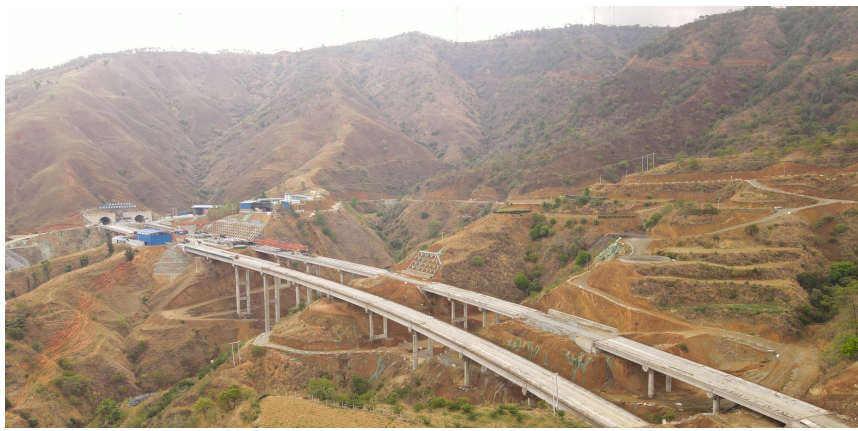
建设中的沿江高速宁攀段。省交通厅供图
