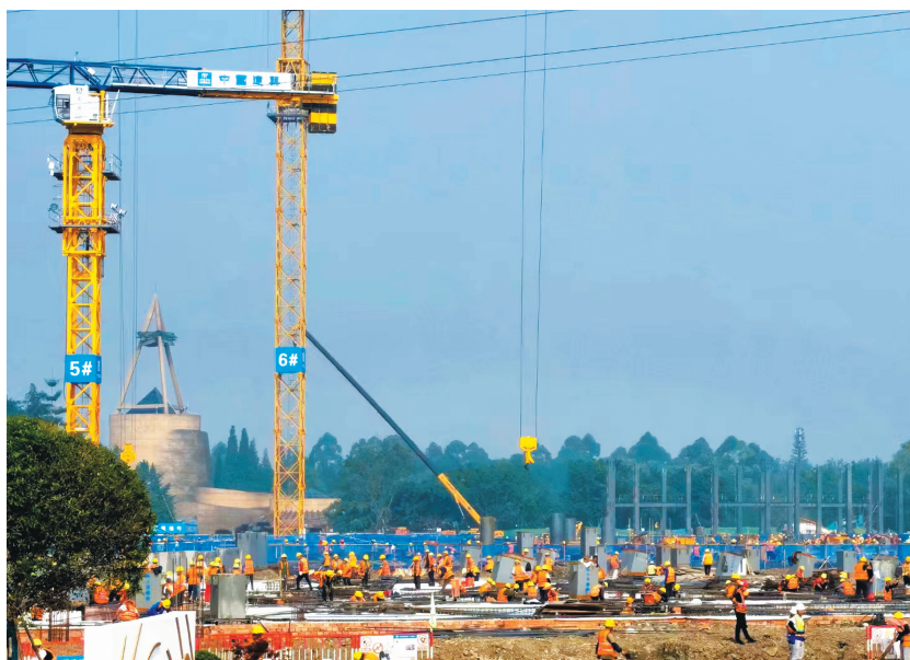
工人们正在热火朝天施工。
