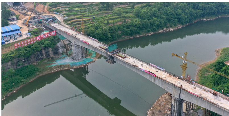
5月31日，汉巴南铁路巴河大桥顺利合龙。蜀道集团供图
