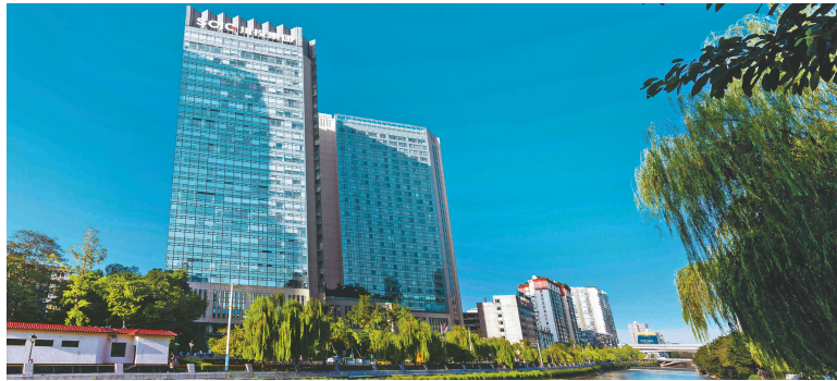
川投集团总部大厦。
