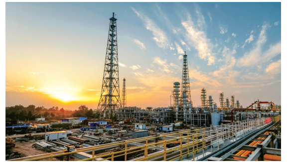
磨溪天然气净化厂。
