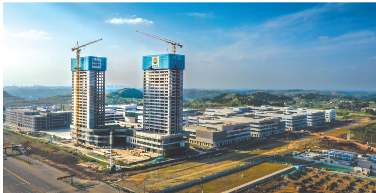
正在加快速建设的成都空天产业功能区。邹文润 摄
