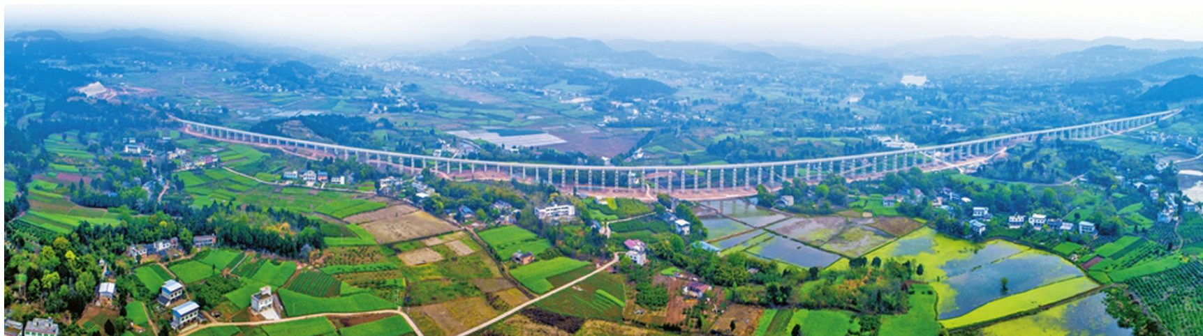
毗河供水工程乐至段廖家坝渡槽。(资料图)
