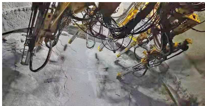
泸石项目隧道大多采用反打出洞的施工方式。蜀道集团藏高泸石公司供图
