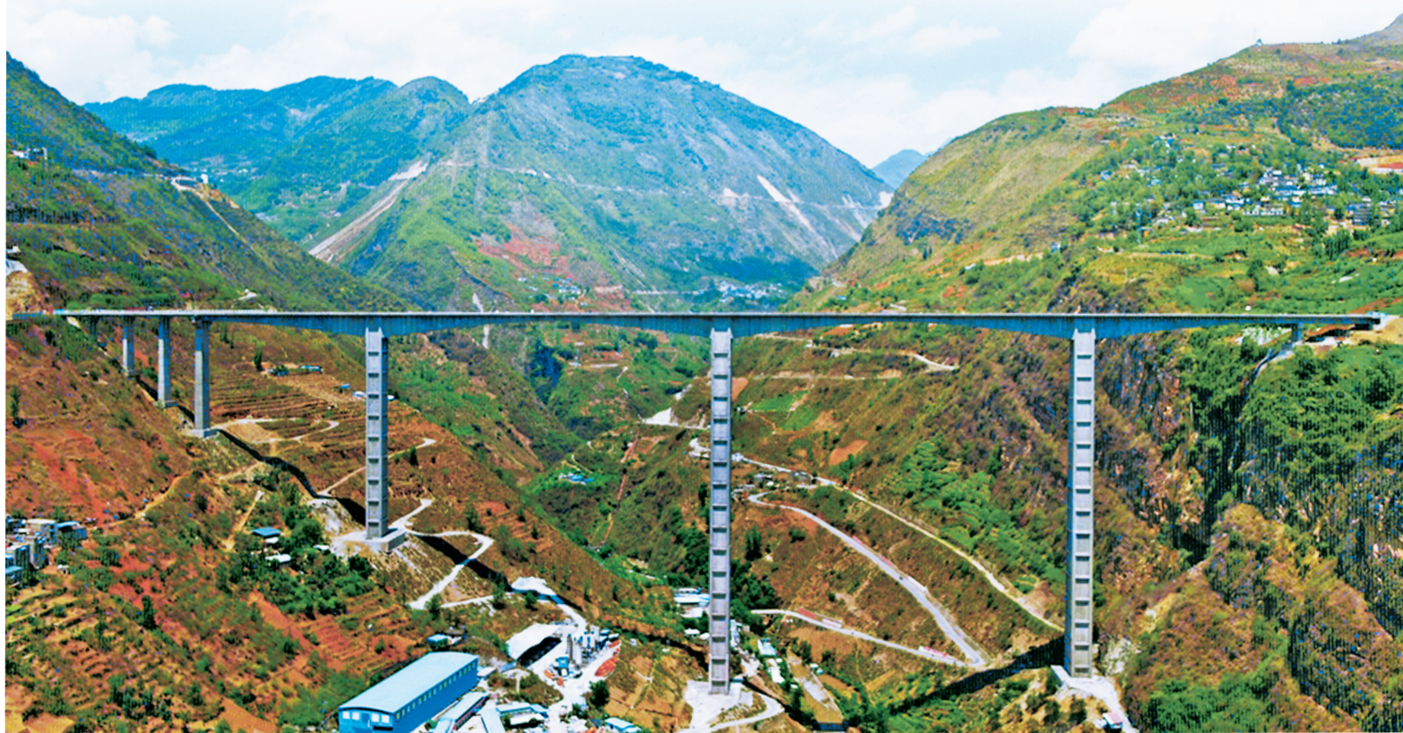
即将通车的金阳县三峡连心桥。
