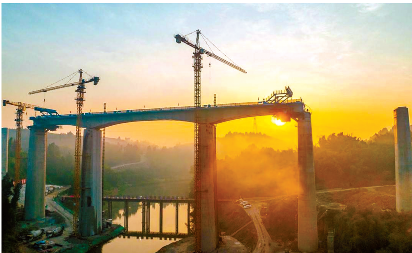
5月5日,成自高铁球溪河双线大桥连续梁完成合龙段混凝土浇筑。 成兰铁路公司供图
