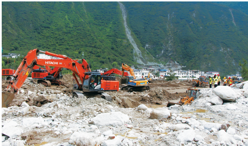
应急抢险现场。
