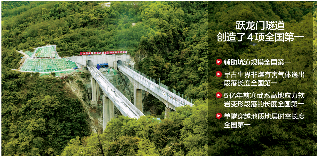
成兰铁路跃龙门隧道洞口航拍图。成兰铁路公司供图
