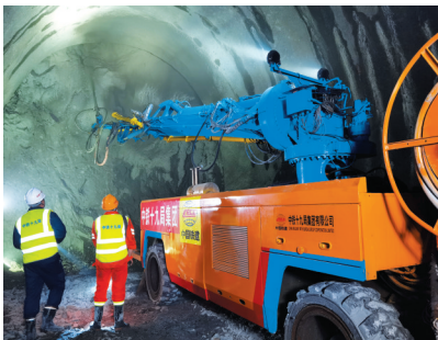
工人在隧道内施工。
