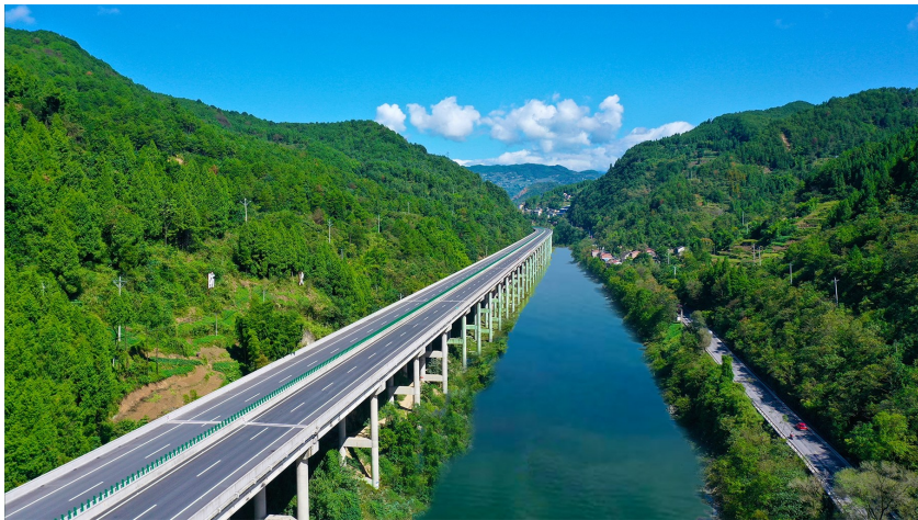
建设中的开州城口高速公路，预计今年内通车。开州区委宣传部供图
