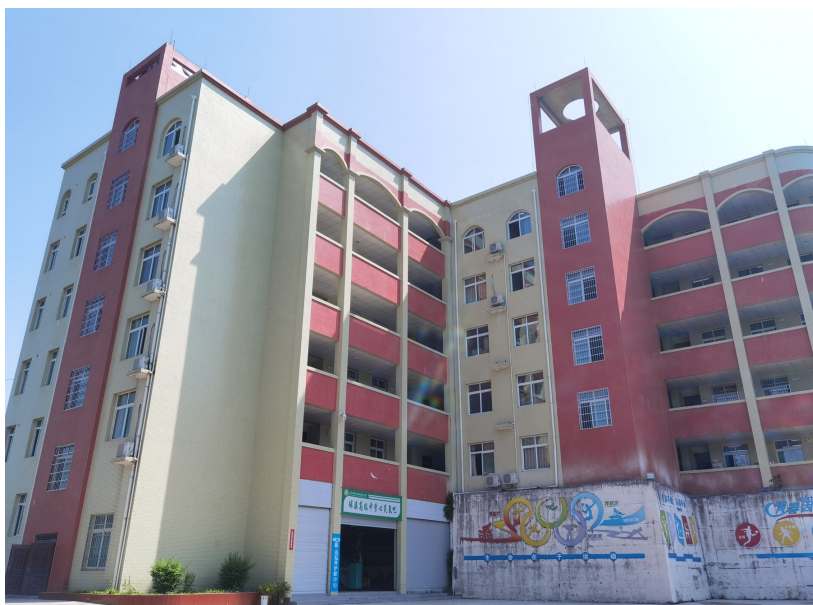
球溪中学新建的科技楼。
