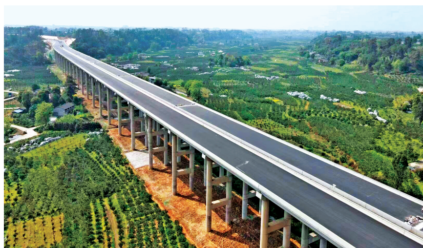
蒲名快速路西门沟大桥。蒲江县交通运输局供图
