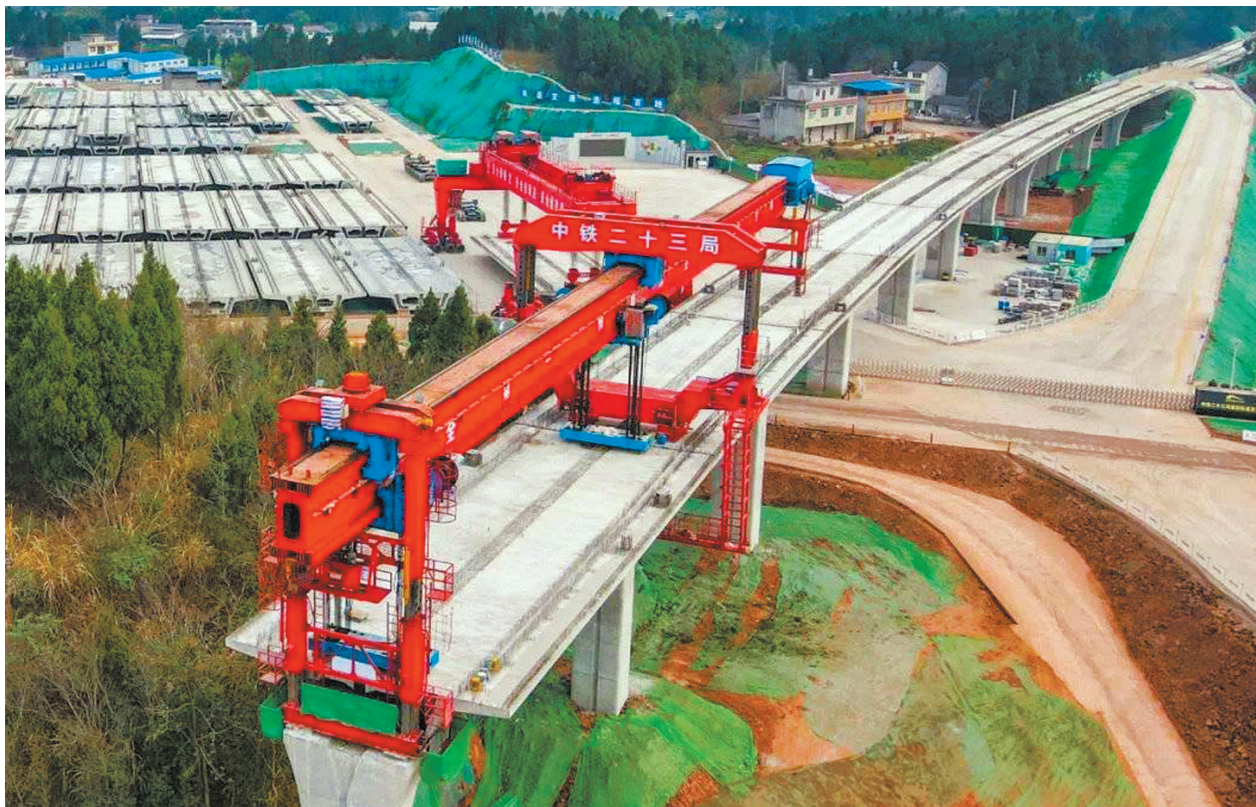
轨道交通资阳线高架段建设现场。
