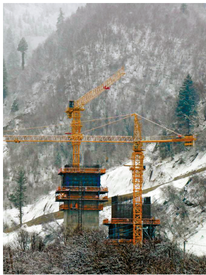
风雪中的久马高速施工现场。
