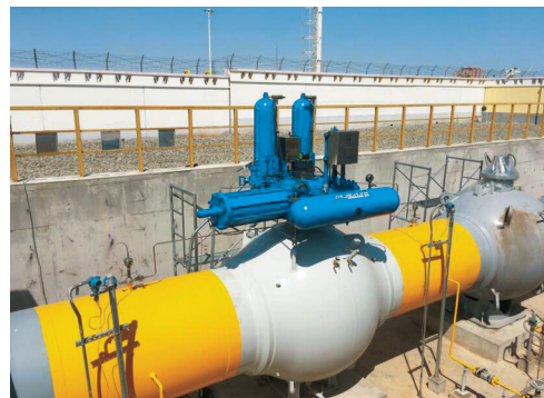
油气管道关键设备国产化现场试验。
