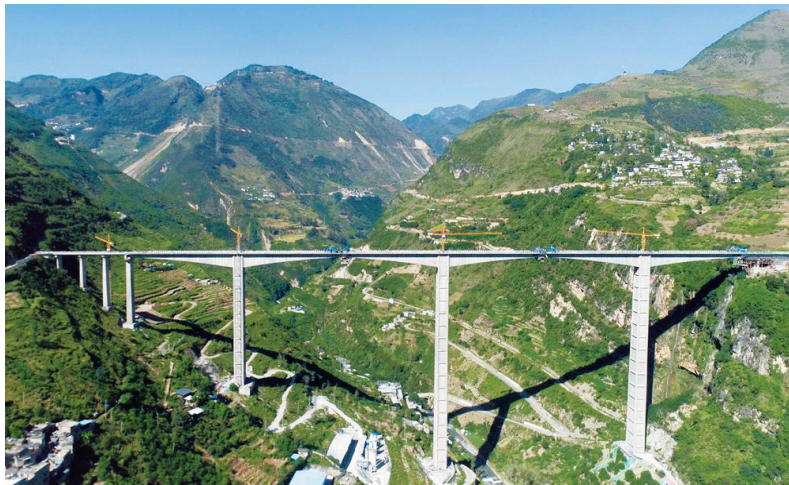
金阳河“三峡连心桥”工程已完成合龙。
