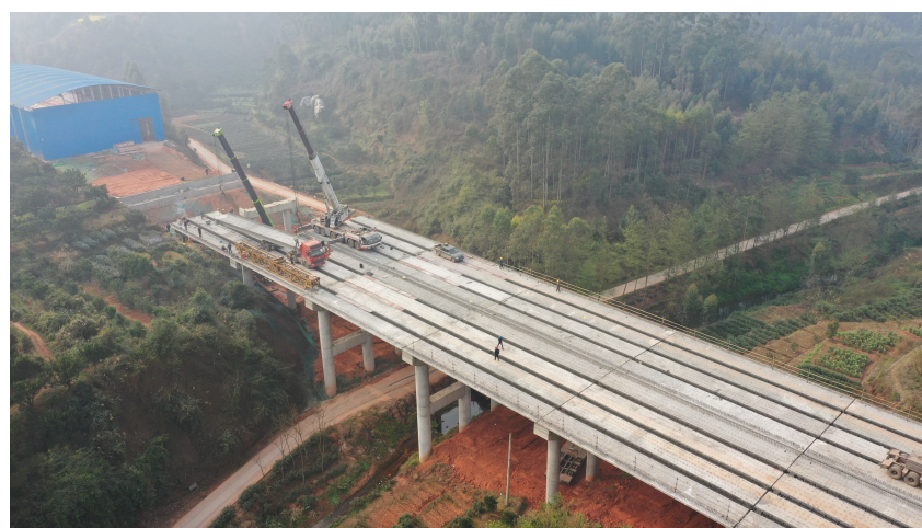
乐西高速过桥处大桥顺利架通。中铁二局四公司供图
