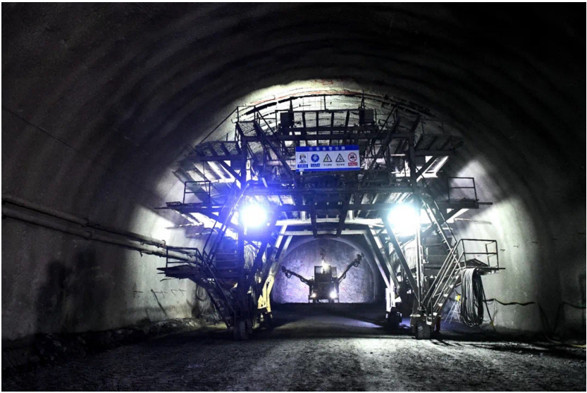
成昆铁路复线小相岭隧道建设进入最后冲刺阶段。(中铁隧道局供图)
