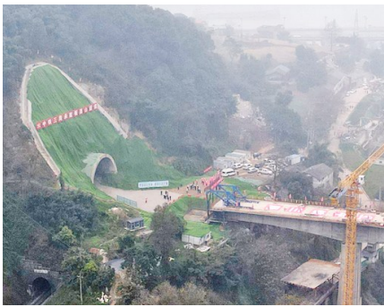
自宜高铁板栗山隧道上跨既有铁路线。
