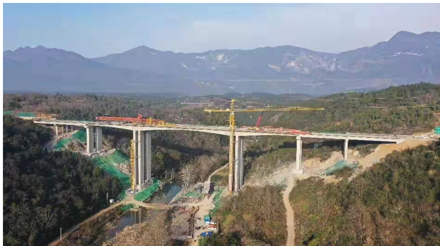
九绵高速建设现场。
