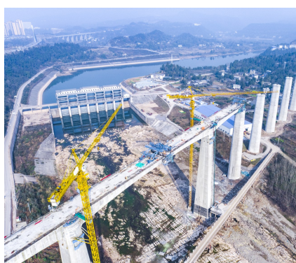
恩阳河特大桥主桥连续刚构合龙。 蜀道集团供图
