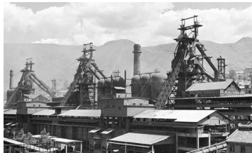
我国第一个自己设计、自己制造设备、自己施工安装的大型钢铁联合企业——攀枝花钢铁公司第一期工程建成投产。这是攀钢的高炉群。（新华社资料图）
