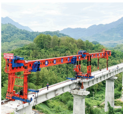
完成架梁的班那汉跨湄公河特大桥梁。中铁八局供图
