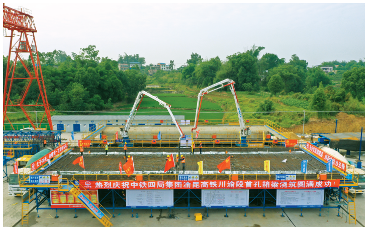
6月2日，渝昆高铁川渝段首孔简支箱梁在泸州市江阳区完成浇筑。
