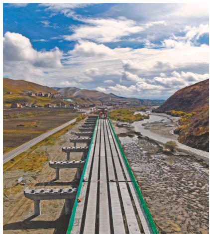
久马高速阿坝段刚坤玛特大桥半幅贯通。(蜀道集团供图)
