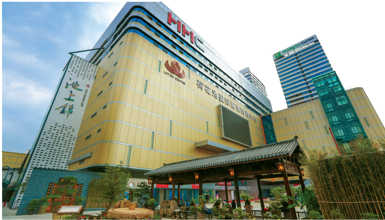
荷花池片区城市有机更新。
