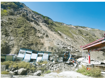
被落石砸烂的板房。
