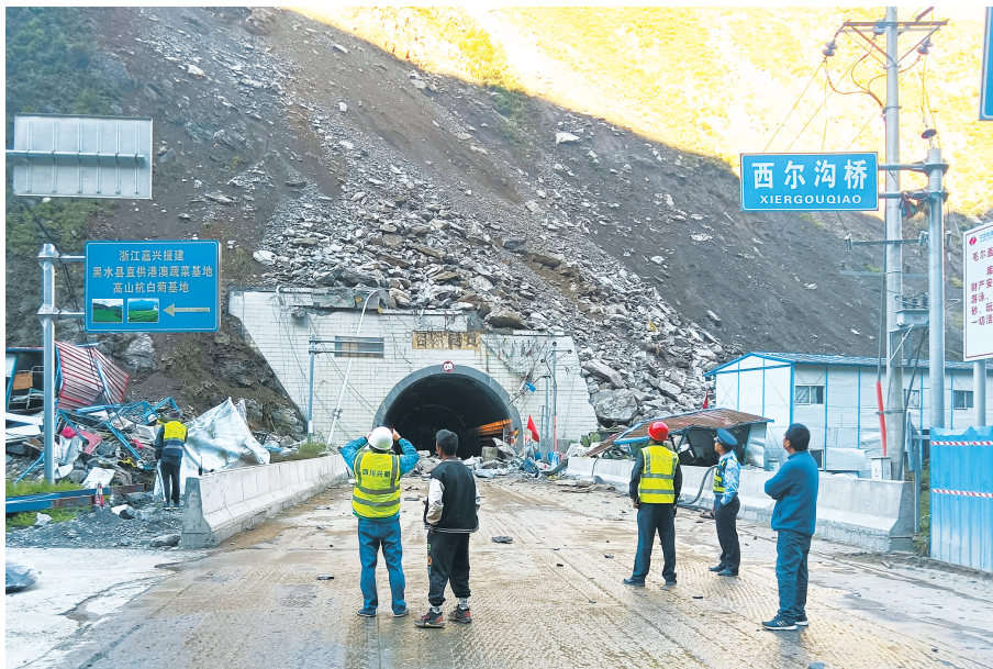
西尔隧道口上方山体崩塌现场。省交通运输厅公路局供图
