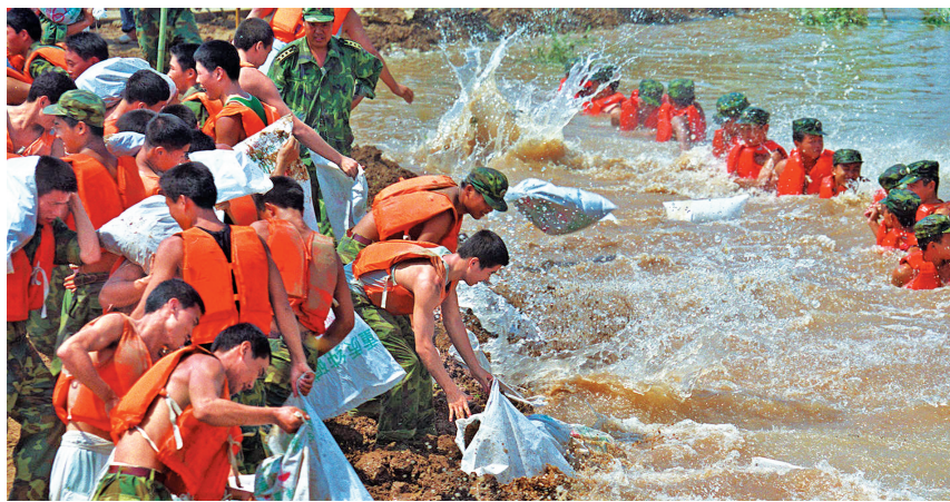
湖北石首久合垸乡团山河支堤出现“管涌”险情,解放军官兵立即奔赴险段,以血肉之躯挡住肆虐的洪水,减低洪水的冲击力,同时加固堤防(1998年8月11日摄)。
