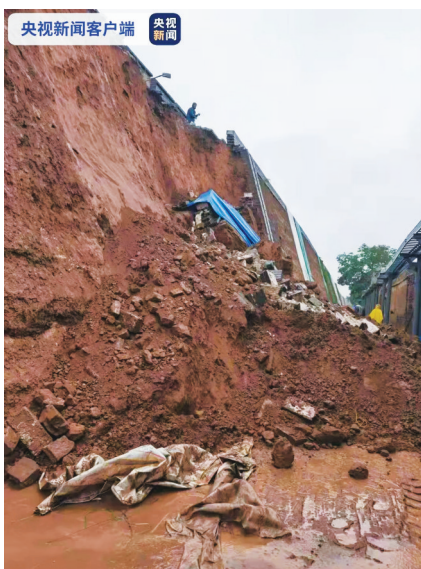
平遥古城墙第84号内墙发生局部坍塌,坍塌长度约25米。
