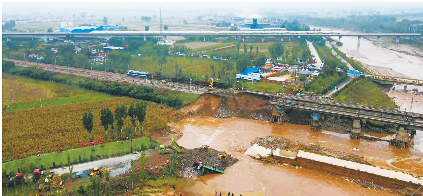
受山西持续降雨影响,南同蒲铁路线祁县至东观间昌源河大桥桥台6日被冲垮,枕木悬空,影响行车。图据人民日报微博
