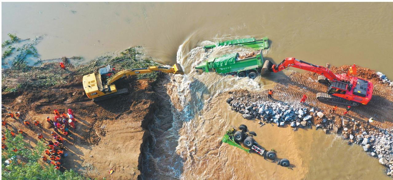
满载石料的重型卡车被推入卫河鹤壁市浚县新镇镇彭村段的决口处(无人机照片)。新华社发
