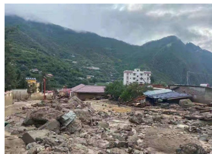
泥石流经过的地方一片狼藉。
