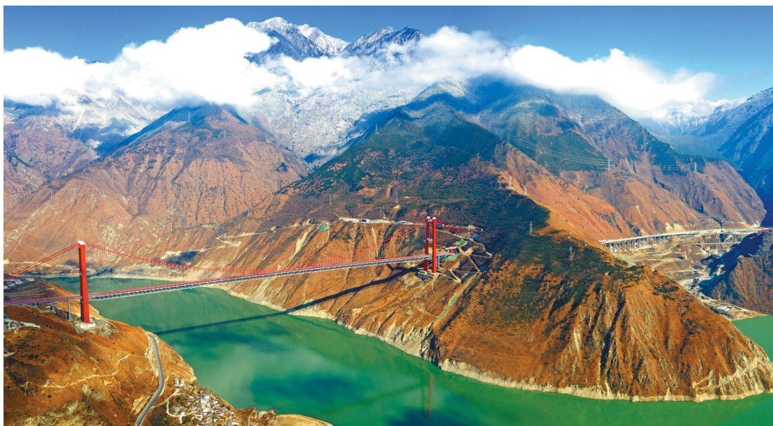
川藏第一桥——雅康高速泸定大渡河大桥。
