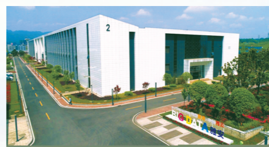
位于雅安的中国大数据中心。
