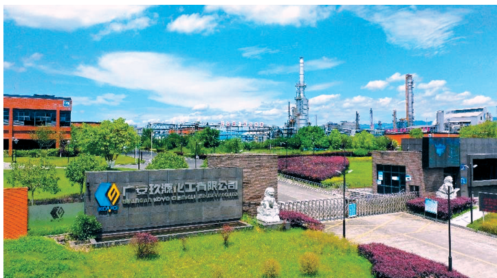
玖源化工产业园。广安经开区供图
