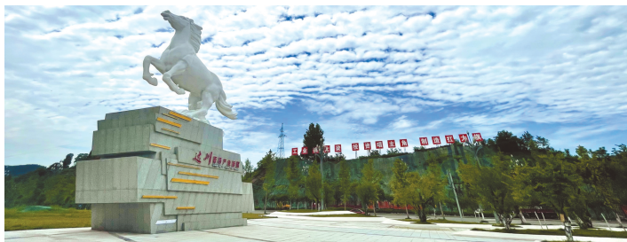
正在建设中的达川区白马产业新区。
