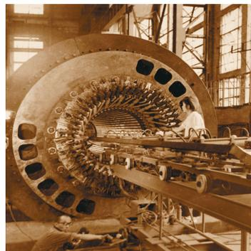
1967年第一台5万千瓦汽轮发电机投产,开始了东方电机火电设备的制造。
