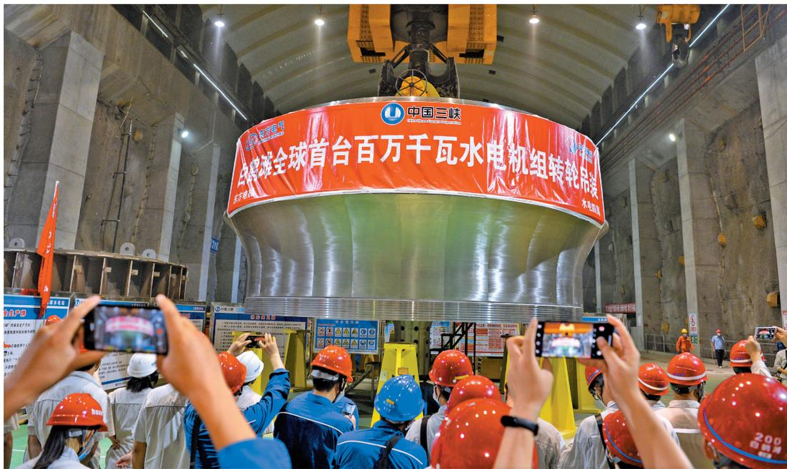
德阳制造,全球首台百万千瓦水轮发电机组转轮在白鹤滩水电站完成吊装。
