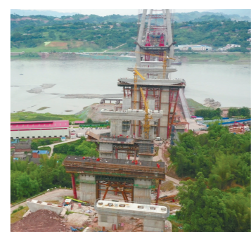
建设中的宜宾临港长江大桥。四川路桥宜宾临港长江大桥项目部供图
