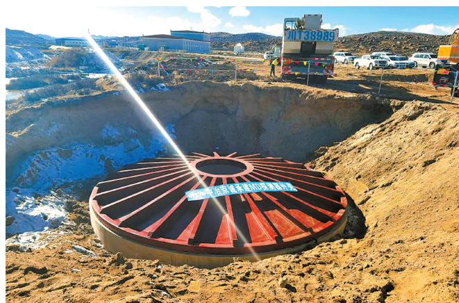
▲2020年12月，最后一个缪子探测器建成，标志着高海拔宇宙线观测站缪子探测器阵列主体工程完工。资料图据四川日报
