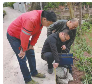
邓勇检查道路工程质量。
