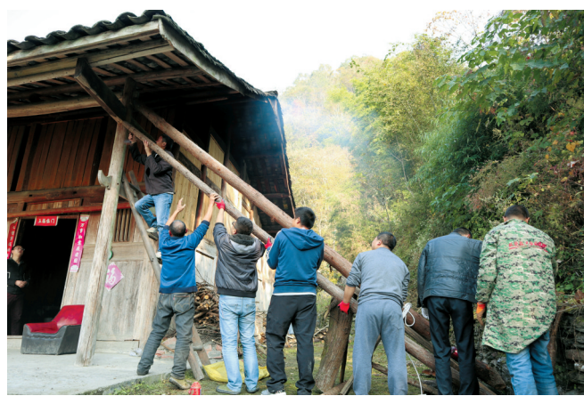
平武组工干部帮助群众加固房屋。
