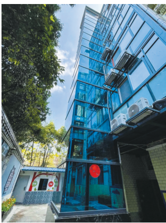
成都锦江区横丁字街40号院部分单元加装了电梯。
