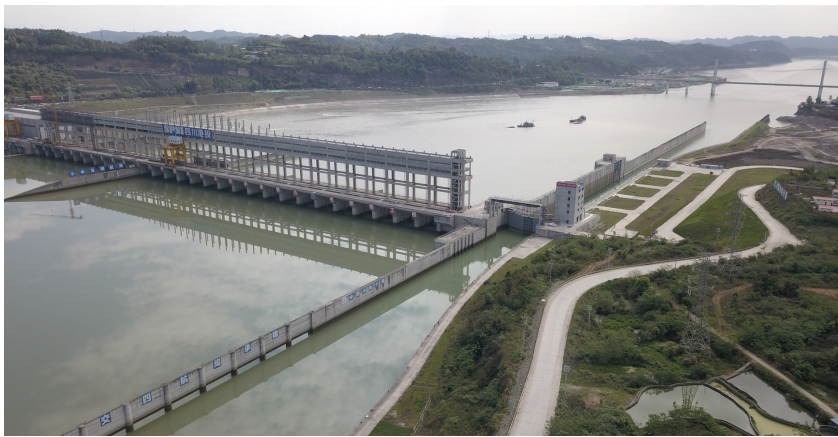
岷江犍为航电枢纽工程。
